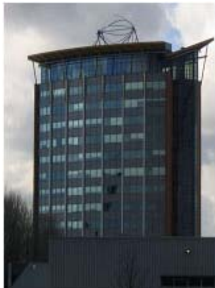
Source : WindWall sur un toit de bâtiment, Pays-Bas.
